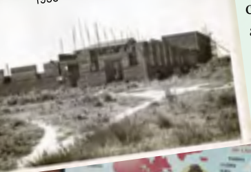
Construcción del Complejo Belvedere 1958 - Araras - SP
